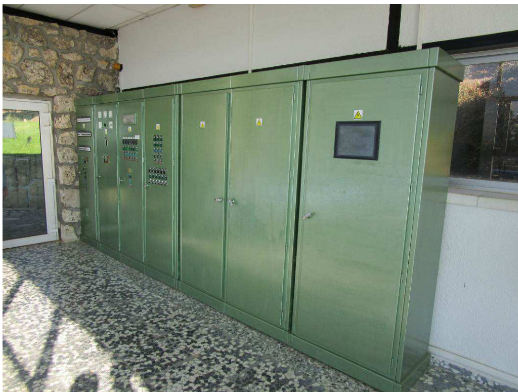
Vista del CCM de la sala de filtros que será sustituido y ubicado en una sala independiente dentro de la galería
