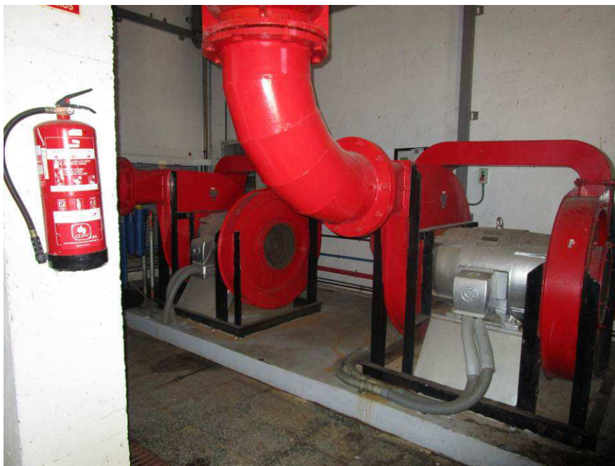
Vista de la sala de máquinas con soplantes centrífugas a desmantelar
