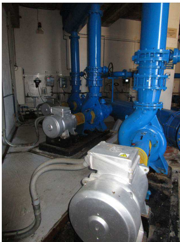
Vista de la sala de máquinas con bombeo de agua para lavado de filtros y colector a sustituir
