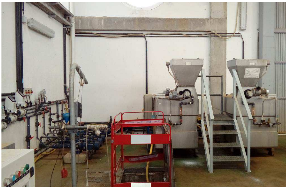
Sistema de dosificación de polielectrolito a centrifugadoras y a espesado por flotación
