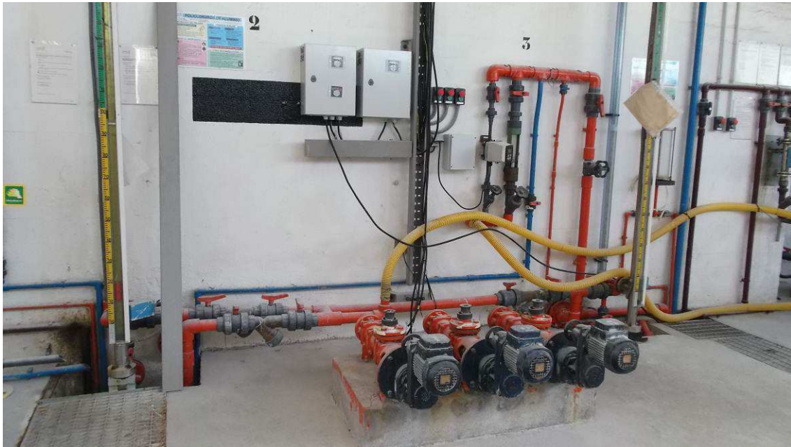
Bombeo actual de dosificación de policloruro de aluminio
