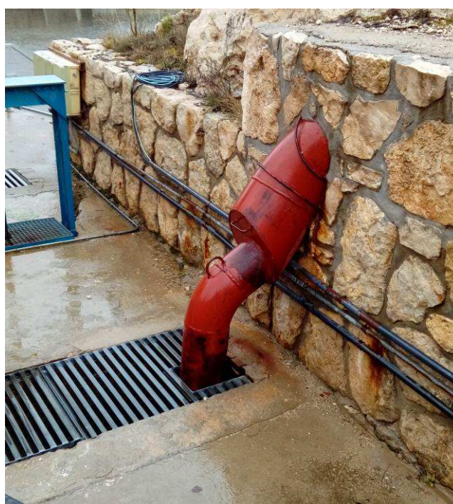
Tubería de llegada de la impulsión de escorrentías al depósito superior de cabecera
