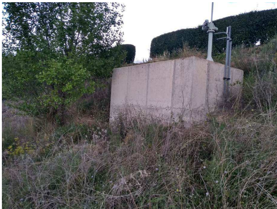
Arqueta de aliviados del agua de lavado de filtros al bombeo de escorrentías batería 1
