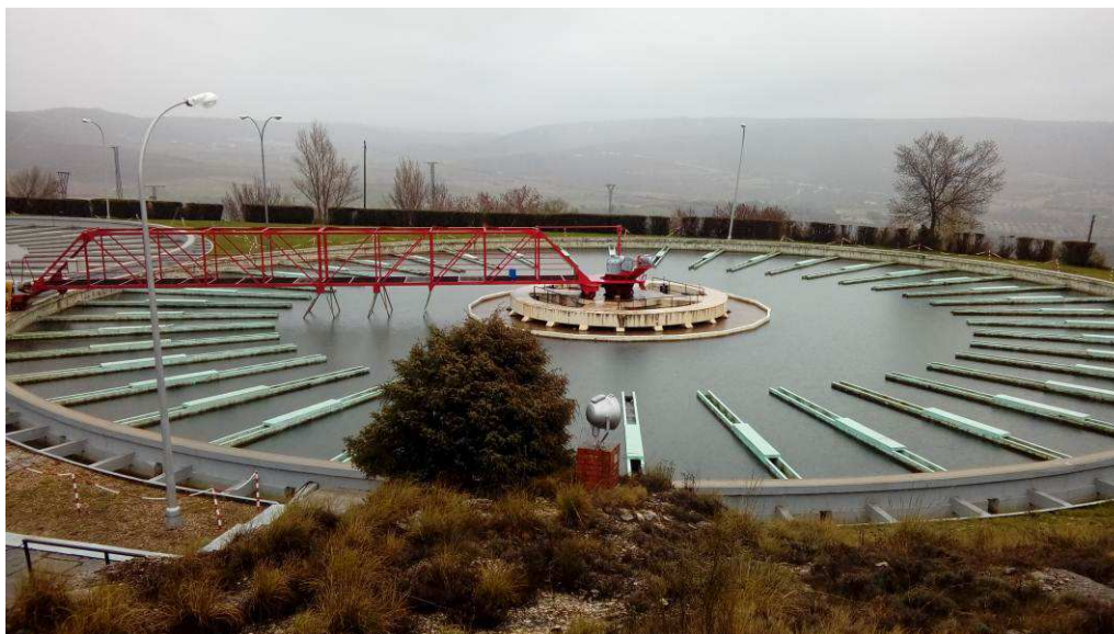
Vista de los decantadores Accelator a los cuales se les hará una impermeabilización
