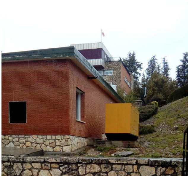
Vista del grupo electrógeno nuevo que dará servicio a la ETAP durante la parada por motivos de conexión en fase de obra
