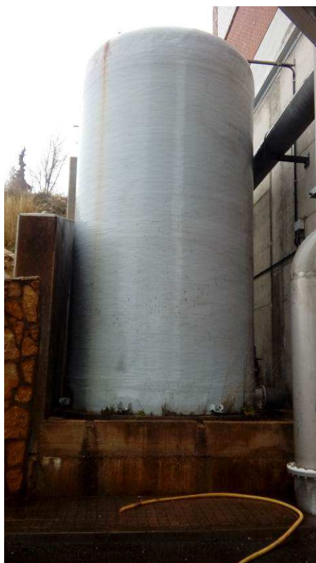
Depósitos de almacenamiento de fangos anexos a la cámara de almacenamiento de purga de fango de los decantadores lamelares a dismantelar
