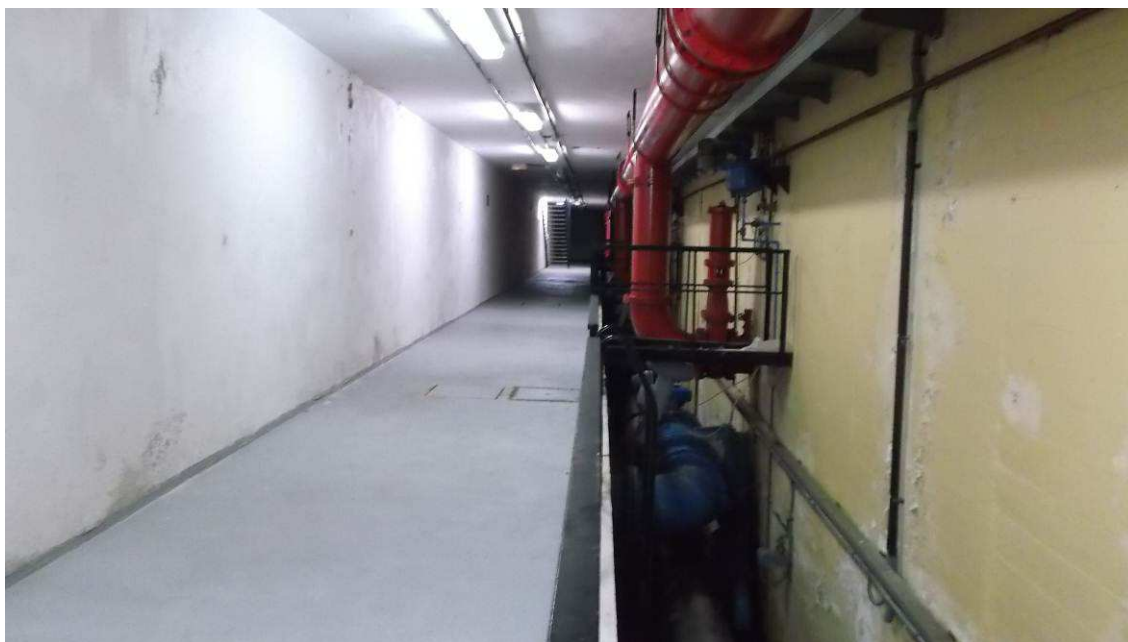
Vista de las tuberías y valvulería a sustituir de la galería de filtros
