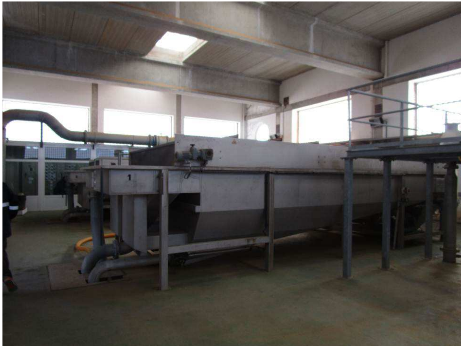
Vista de los espesadores por flotación actualmente fuera de servicio
