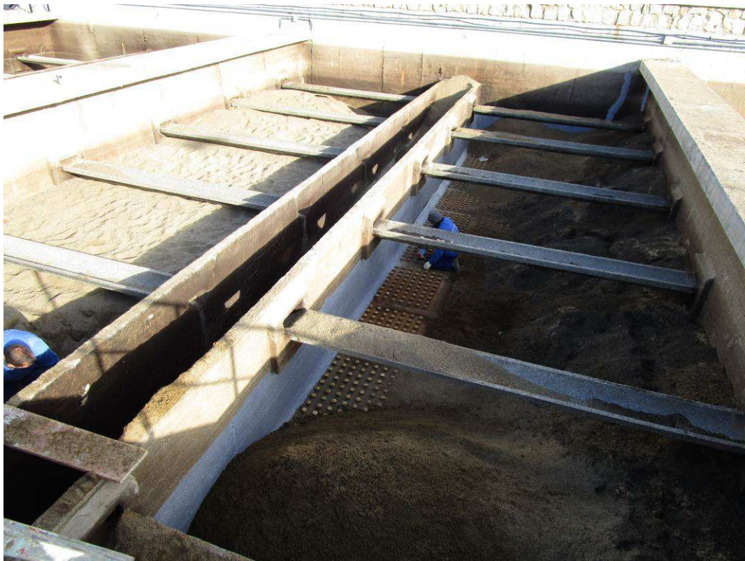
Vista del falso fondo actual de los filtros de arena
