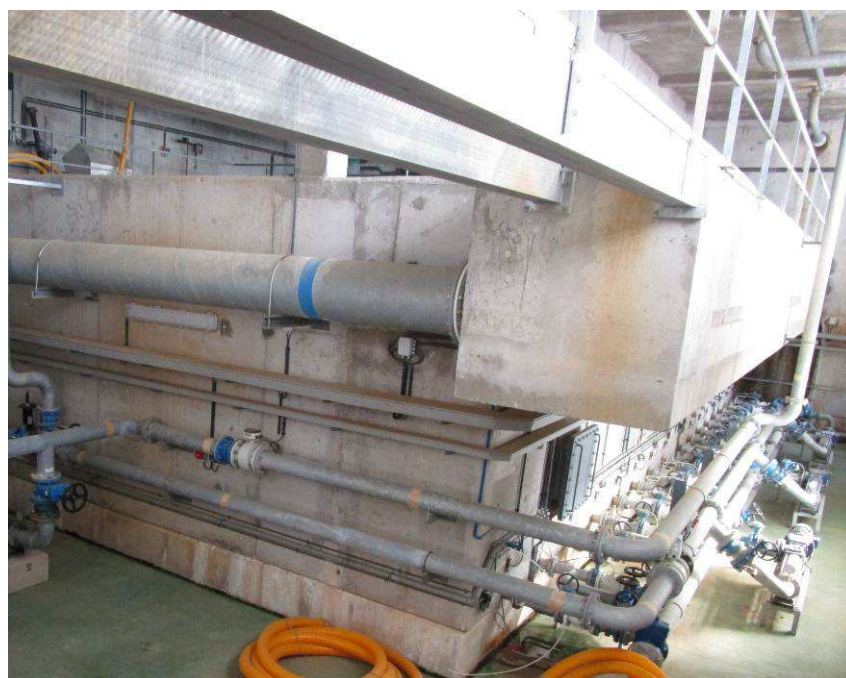
Vista del canal de salida de agua clarificada de los decantadores lamelares y en la parte inferior derecha se ven las bombas de purga de dichos decantadores
