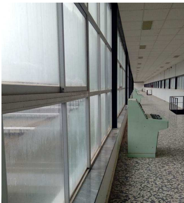
Carpintería metálica de las cristaleras de la galería de filtros a sustituir
