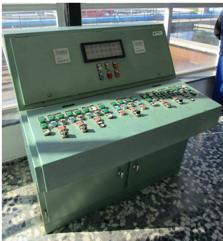
Vista del actual control de los filtros que será eliminado pues el sistema de filtración será automatizado.
