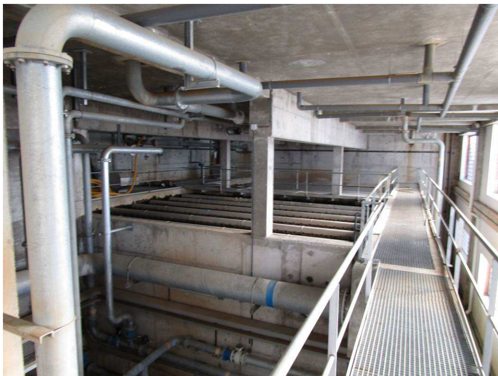
Vista de los decantadores lamelares en planta inferior del edificio
