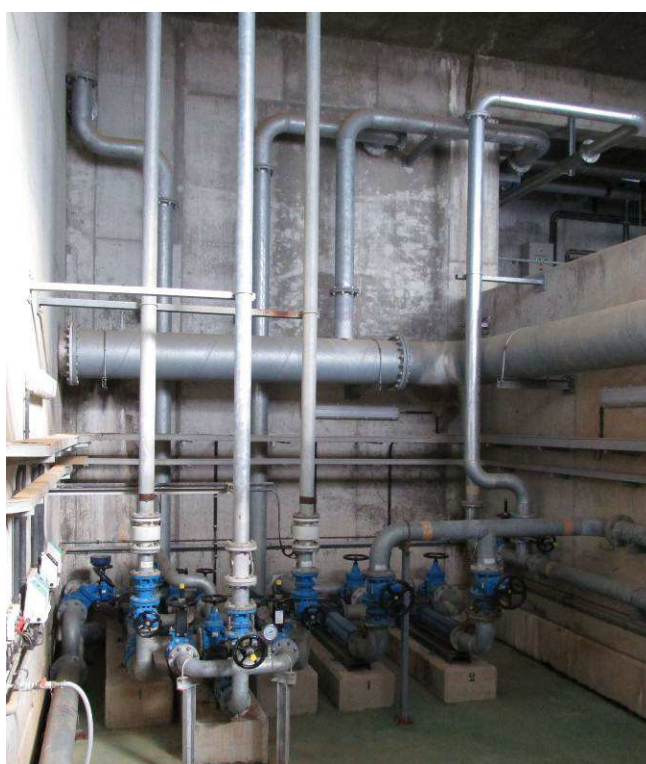
Bombeo de fangos desde la cámara de almacenamiento de fangos hasta los espesadores de flotación y las centrifugadoras
