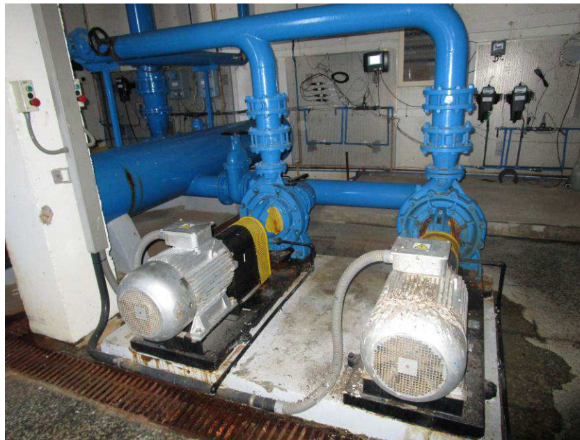
Vista de la sala de máquinas con bombeo de agua servicios auxiliares a sustituir
