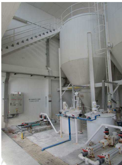
Instalación actual de dosificación de hidróxido cálcico
