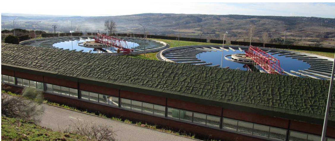
Vista de la cubierta de impermeabilización del tejado de una de las galerías de filtro
