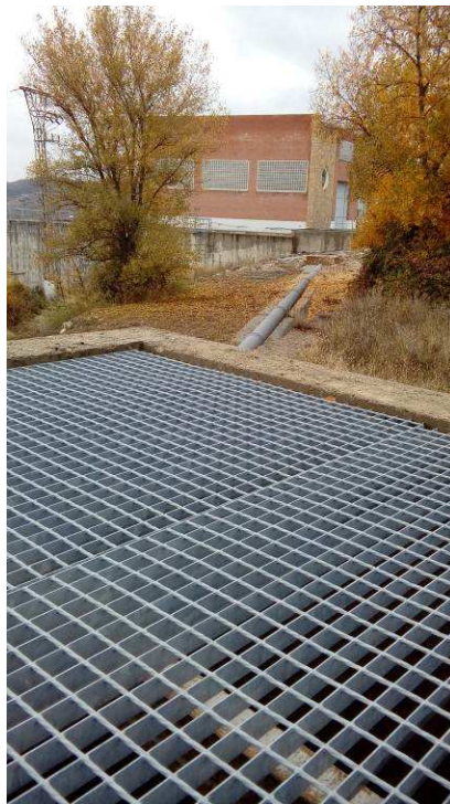
Arqueta de aliviados del agua de lavado de filtros al bombeo de escorrentías batería 2
